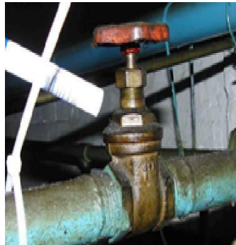
ပုံ ၈-၆ လေယိုစိမ့်မှု (leakage) ဖြစ်နေသည့်နေရာများအား အမှတ်အသား(tagged) လုပ်ထားပုံ
