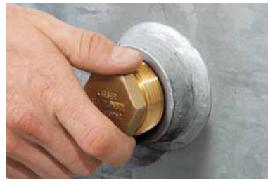
ပုံ ၅-၁၂ Inspection aperture - receiver များကို သန့်ရှင်းရေးလုပ်ရန် (cleaning)၊ ပြုပြင် ထိန်းသိမ်းရန် (maintenance) နှင့် စစ်ဆေးရန် (inspection)အတွက် လွယ်ကူအောင် ပြုလုပ်ထား သင့်သည်။
