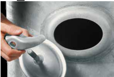
ပုံ ၅-၁၂ Inspection aperture - receiver များကို သန့်ရှင်းရေးလုပ်ရန် (cleaning)၊ ပြုပြင် ထိန်းသိမ်းရန် (maintenance) နှင့် စစ်ဆေးရန် (inspection)အတွက် လွယ်ကူအောင် ပြုလုပ်ထား သင့်သည်။
