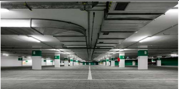
ပုံ ၇- ၅၈ မြေအောက်ကားရပ်နားရန် နေရာလေဝင်လေထွက် duct များ (basement car park duct)
