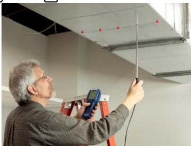
ပုံ ၅-၂၁ Duct test holes
