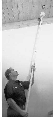
ပုံ ၈-၁၉ Technician using a heat detector tester
